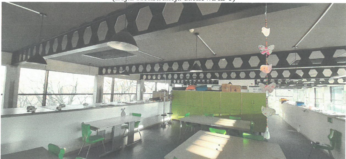
(Zdj. 3 Konstrukcja dachowa nr 2)
