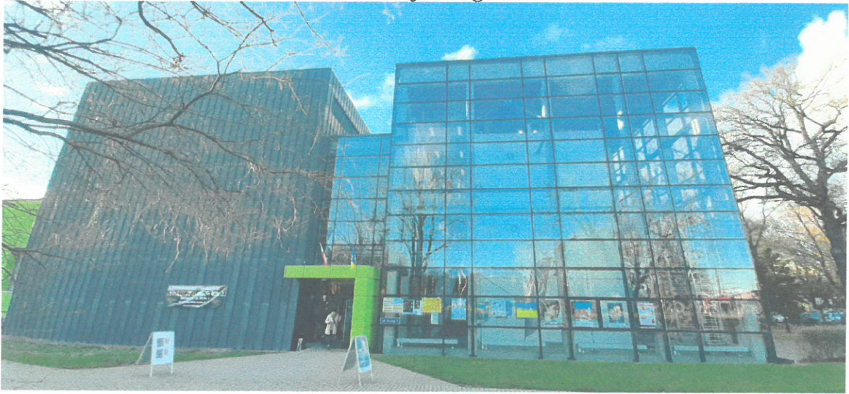
(Zdj.1 Budynek CK Kołobrzeg)
