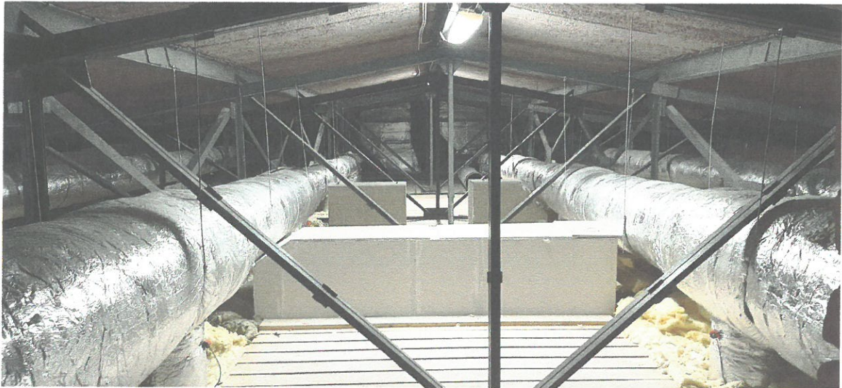
(Zdj.2 Konstrukcja dachowa nr 1)
